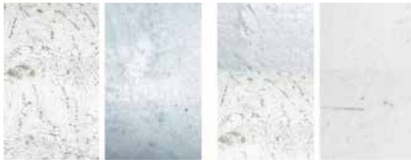
亜鉛めっき鋼板 やけ発生 スプレーを塗装 3か月暴露後
